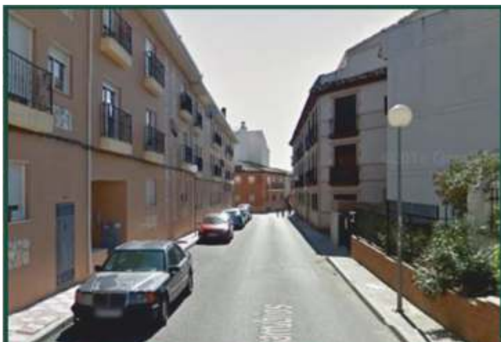
Calle Casarrubios de Cedillo del Conde. En el edificio de la izquierda hay numerosos okupas; no tantos en el inmueble de la derecha.
